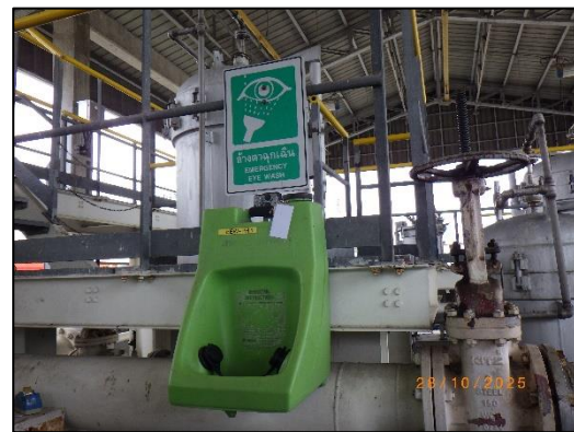
รูปที่ 2-18 อ่างล้างตาและล้างตัวฉุกเฉิน
