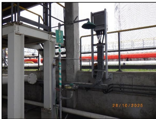
รูปที่ 2-18 อ่างล้างตาและล้างตัวฉุกเฉิน
